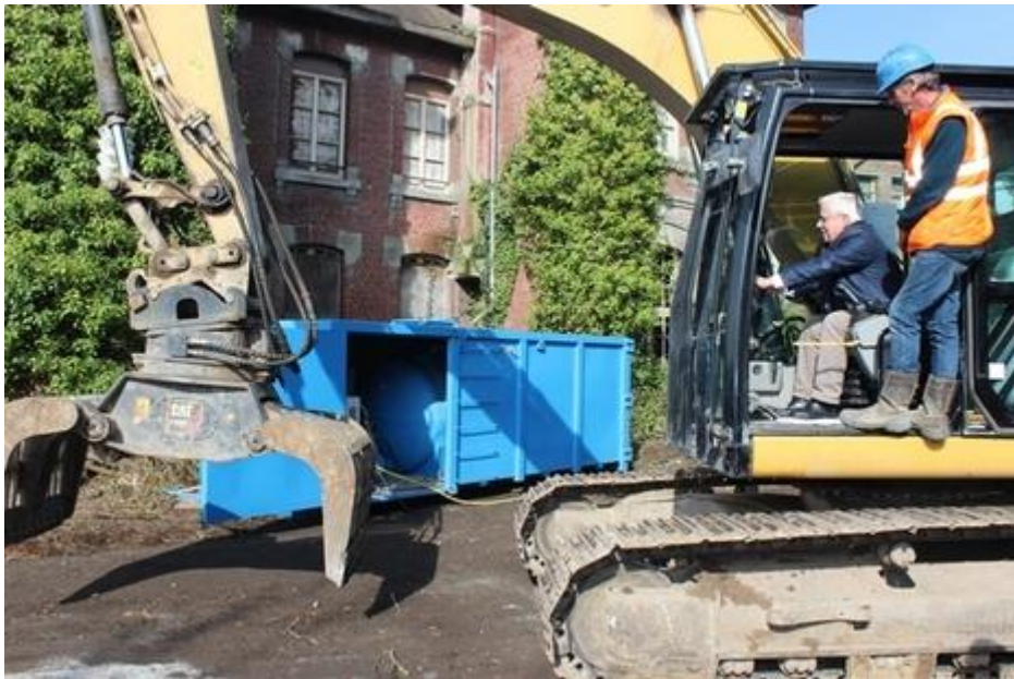
Bernard Delaby a ensuite symboliquement manié la pelleuse pour démarrer la déconstruction du site.
